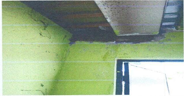
Foto 6: Mejoramiento en canales en aulas y caídas de agua.
