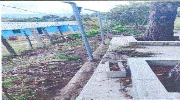
Foto 3: Mejoramiento de muro perimetral e instalación de tubo para base de maya.
