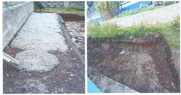
Foto 2: Nivelación de terreno en pared de aulas
